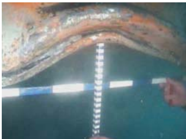
Figure 2 Damage measurement Slika 2 Izmjera oštećenja
